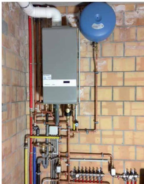
La Cube Duo offre ainsi un niveau de fiabilité supérieur à celui des chaudières murales au gaz traditionnelles. Il s'agit en somme d'une chaudière à condensation plus robuste, ainsi que d'une installation simple et abordable qui s'avère moins énergivore et donc mieux classée en termes de performance énergétique, grâce aux deux pompes de circulation en moins dans l'installation. La Cube Duo est la nouvelle référence en matière de chaudière à condensation pour les nouvelles habitations.
